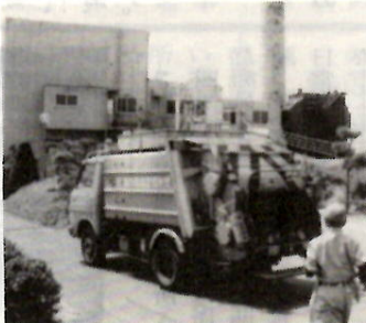
亀泉清掃工場
