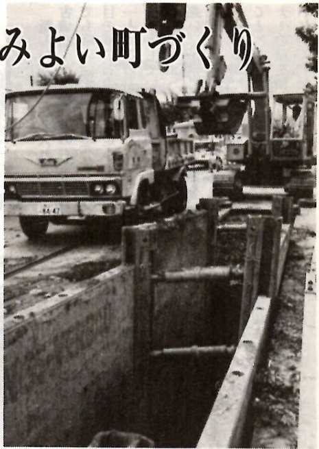
下水道管布設工事（三俣町三丁目）
