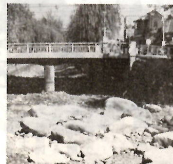
断水中に行われた魚床づくり工事
