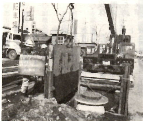
管渠（かんきょ）下水道管の布設工事
