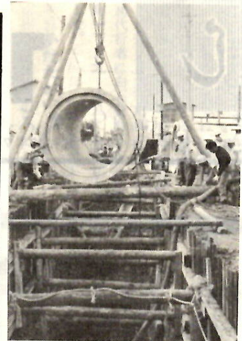
下水道管布設工事は急ピッチですすめられています
