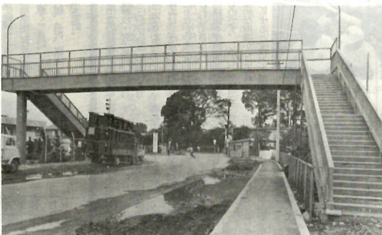
プール付近に歩道橋を新設
